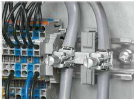
1 DIN rayına paralel topraklama ayaklı taşıyıcı
