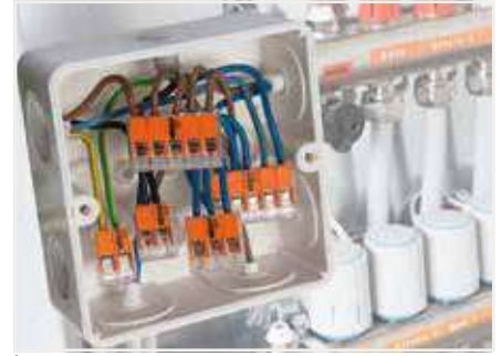
İnce telli iletkenlerin bağlantı kutularında kablolanması
